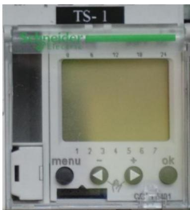
3. Путем одновременного нажатия двух нижних кнопок, находящихся под защитным стеклом на таймере INP не менее 2-х секунд. На экране появиться индикатор «Off» ручного управления, - ручное управление отключено.
