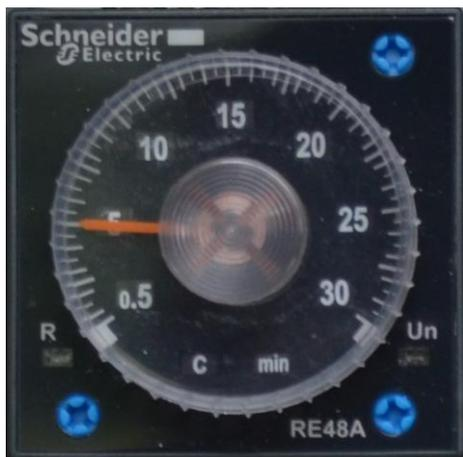
Реле времени регулирует время работы шнека после остановки обезвоживателя в автоматическом режиме.
